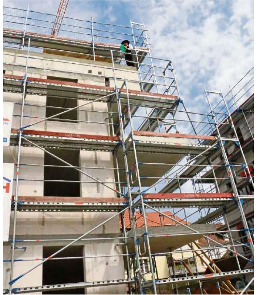
Vom Dach aus hält Zimmermann Nico Trautwein den Richtspruch. Foto: Köhler-Lindig
